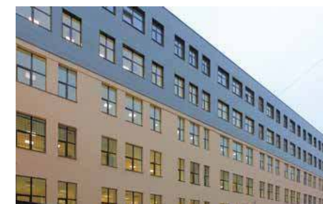
Административно-офисное здание «Тайм-центр», г. Москва
