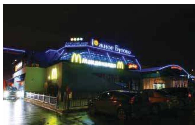
Торговый центр «Южное Бутово», г. Москва
